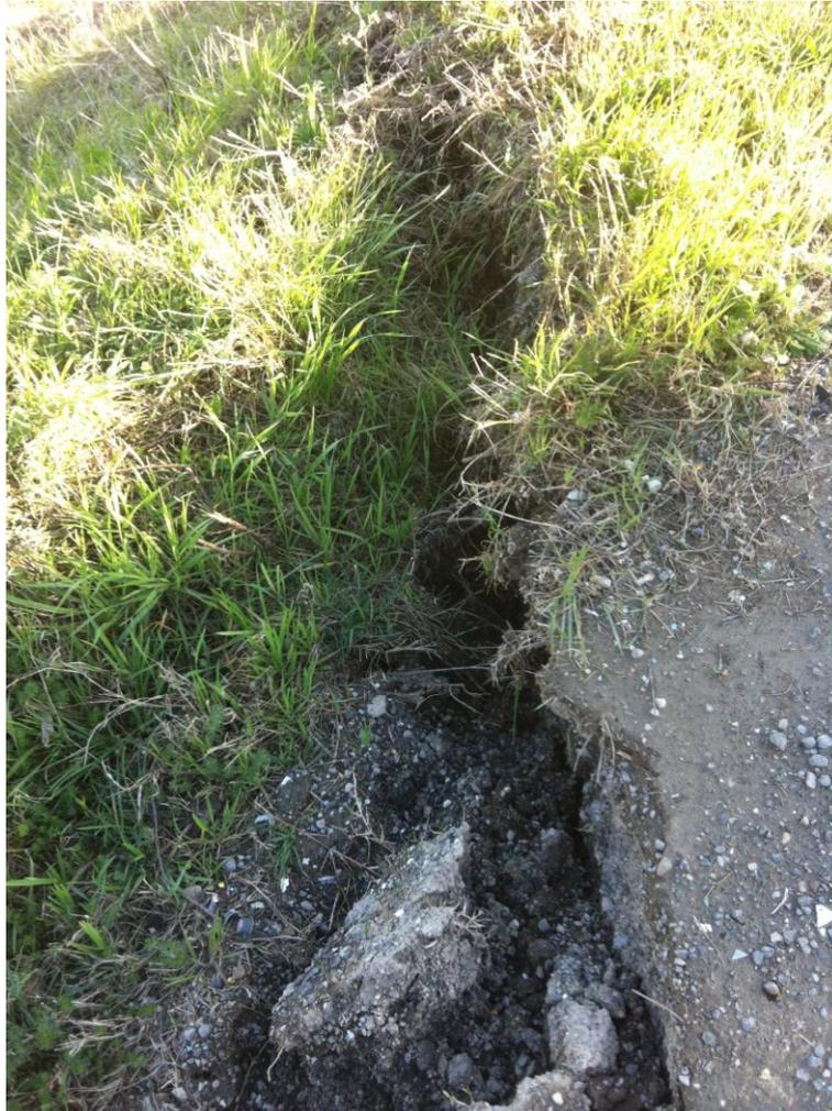
Figura 5: fessurazione dello strato superficiale del terreno nel pendio sovrastante la discarica .
